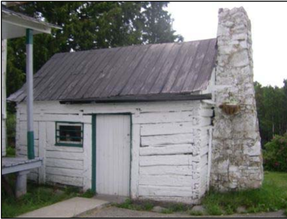
Fournil en pièce sur pièce assemblée à queue d'aronde. Situé au 460, rang Saint-Charles, La Malbaie.
