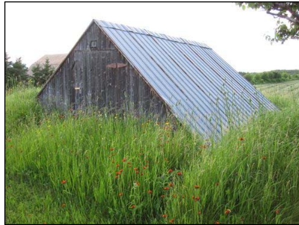
Caveau à légumes situé au 185, rang Sainte-Mathilde Ouest, La Malbaie (Rivière-Malbaie).
